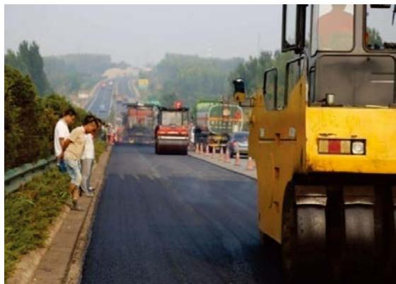
调试及配合比试验等工作，为本次试验段施工生产出了合格的热再生混合料。同时以山东省交通科学研究所、省交通规划设计院等科研单位作为技术支撑，对热再生施工工艺进行优化和提升。本次施工选取上行k8+070-k8+430约1500m<sup>2</sup>，进行热再生AC-25混
